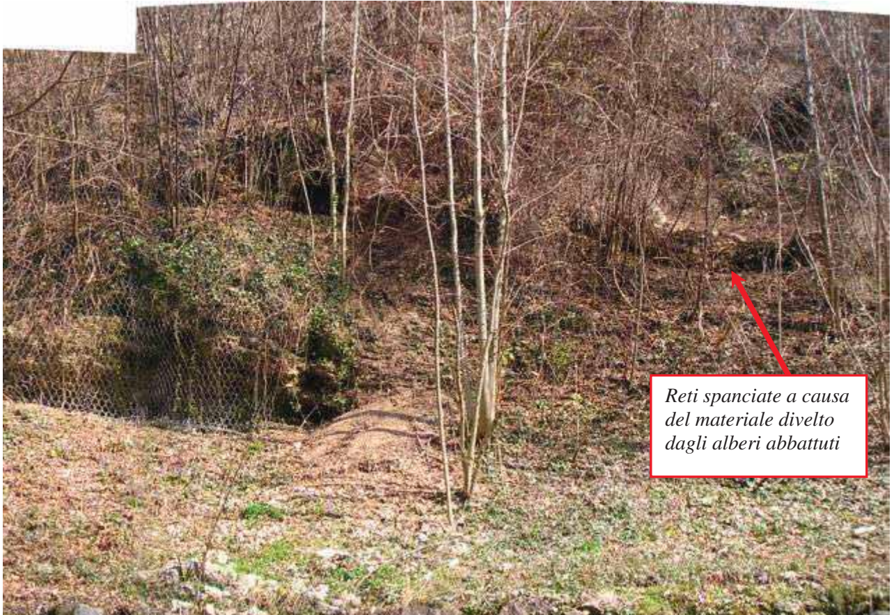
Reti addossate su rupe di conglomerato e reti con paglia parzialmente lesionate e colme di ghiaia e ciottoli che si spanciano verso la strada nel settore Nord
