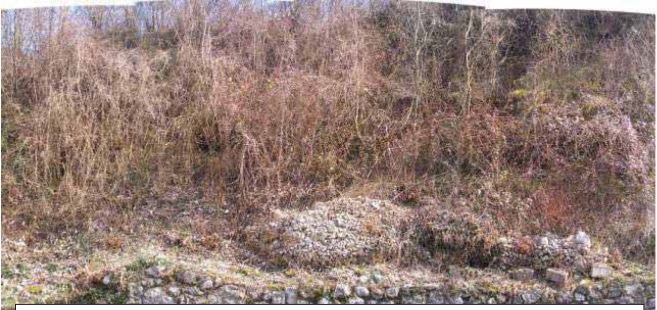
Reti addossate colme di ghiaia e ciottoli che si spanciano verso la strada nel settore Sud
